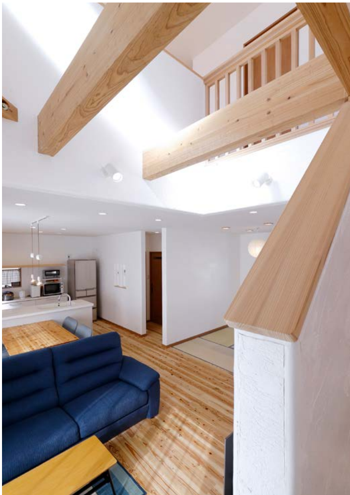
階段から1階、2階を見る。日田杉の迫力ある梁、漆喰の塗り壁など自然素材をふんだんに取り入れる家づくりが「天領木の家」の真骨頂。
