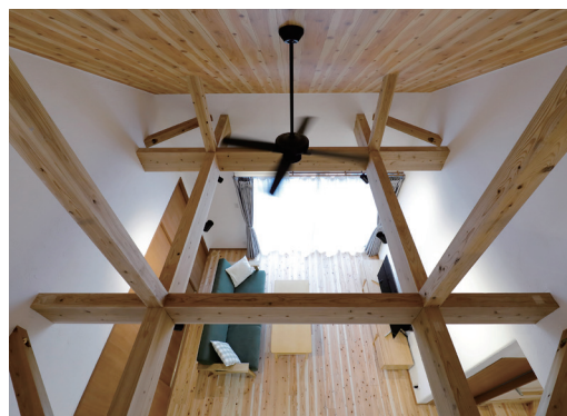
●日田杉の梁が存在感と重厚感をもたらす吹き抜け空間。
