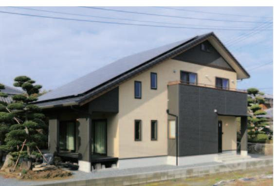
南に面した大屋根に大容量の太陽光パネルを設置している
