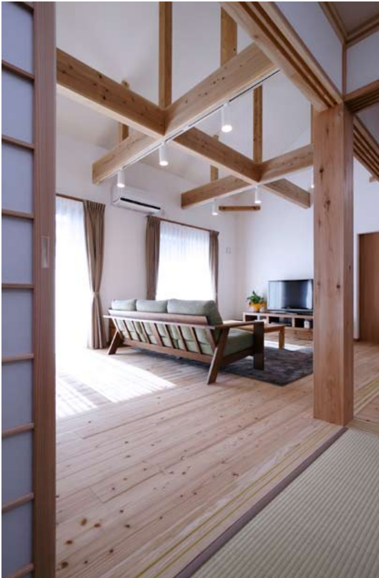
●日田杉の大黒柱、化粧梁が圧倒的な存在感を醸し出すリビング。縦への開放感も大屋根ならではの。
