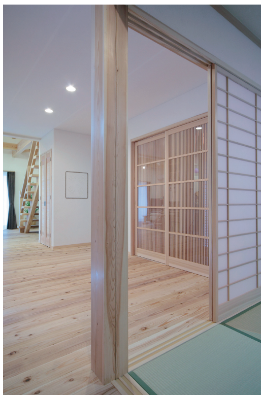
●玄関ホールの引き戸と大黒柱など、日田杉をふんだんに使用。
