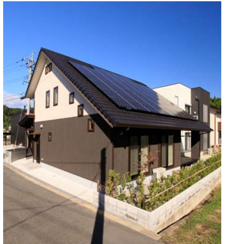
●南に大きく傾斜した片流れの屋根が印象的な石松邸
